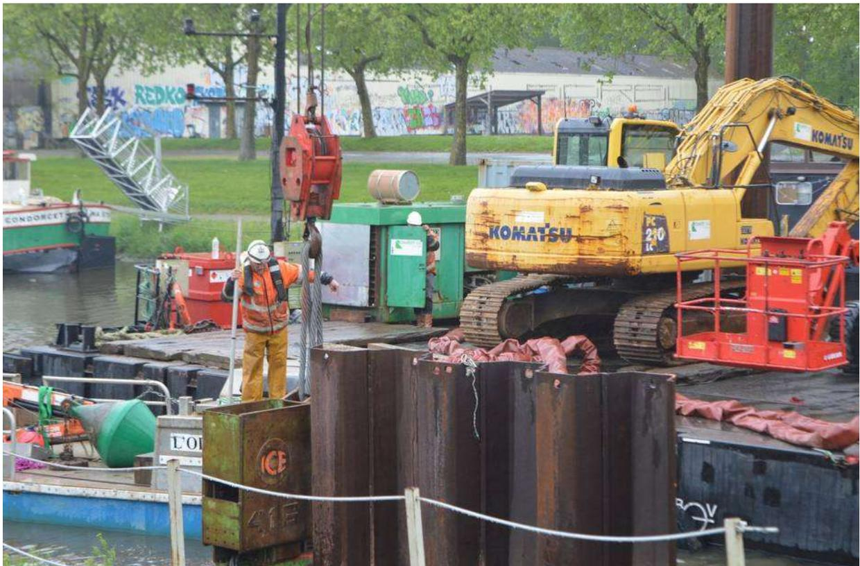
Sur la barge de l'entreprise, installée au milieu du chenal d'accès au port de plaisance, un ensemble de machines et de personnes s'emploie à battre les pieux au pied du quai Surcouf. | Ouest-France
